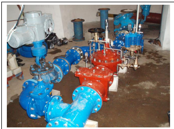
Foto: Příklad osazení bezplovákového ventilu do VV Kojetice
