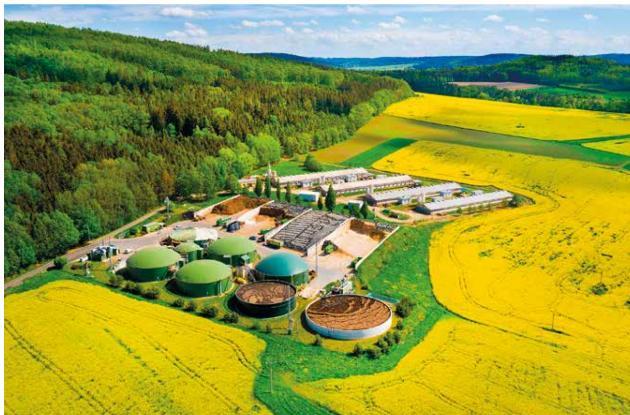
Pro biometanové stanice je výše finanční podpory klíčová.
