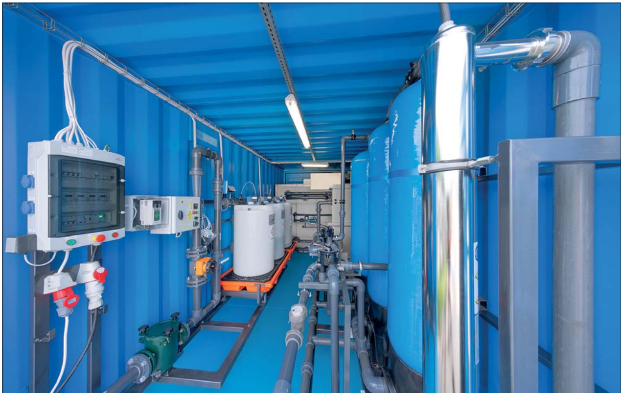
■ Mobilní úpravna vody CCW 10 000 využívá dvoustupňový čistící proces, který si poradí s nejrůznějšími druhy znečištění vody a dokáže adaptivně reagovat i na proměnlivou kvalitu surové vody.
