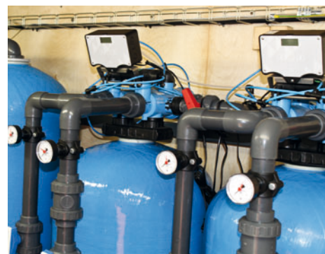
Kontejnerová úprava vody HUTIRA CCW (vlevo celkový pohled, vpravo detail technologie)
